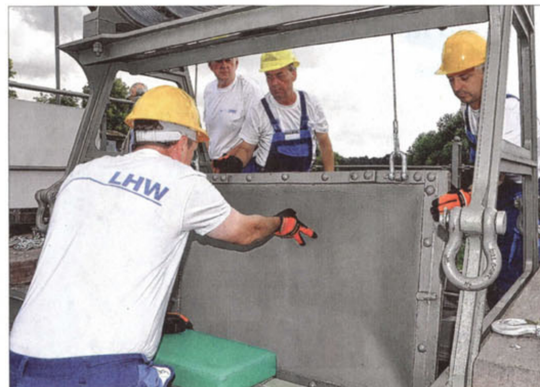
Mitarbeiter des LHW ziehen eine der Schütztafeln hoch.
